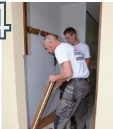
Dépose de l'ancien dormant
