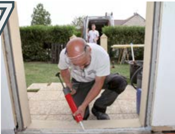
Réalisation de l'étanchéité
