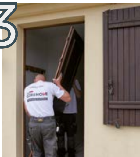
Dépose de l'ancien ouvrant
